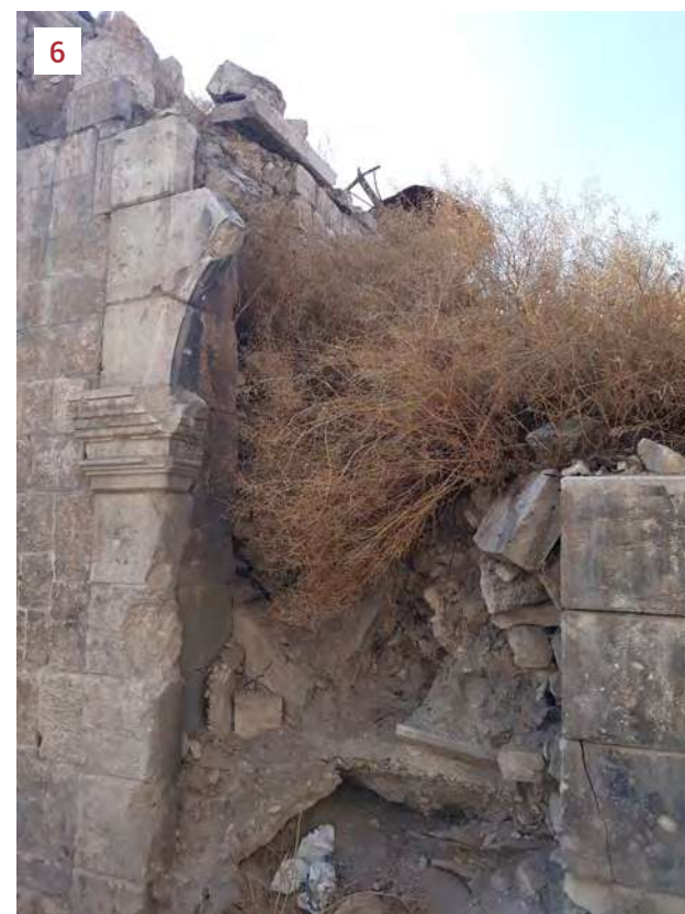
6. The severe damages in the eastern facade (November, 2019) 6. الأضرار الجسيمة في الواجهة الشرقية (تشرين الثاني, 2019)
