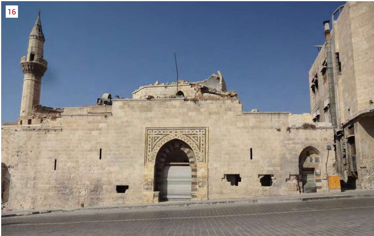
13. The collapsed dome of the southern hall (October, 2019) (تشرين الأول، 2019). 13. قبة القاعة الجنوبية المتهدمة
